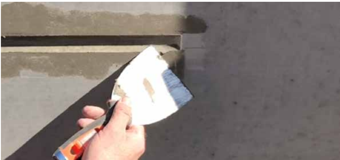
11- Passer une couche de finition avec l'enduit type Lankomur 101 (à renouveler si imperfections résiduelles)
