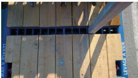
Les Racks Spurgin sont munis d'un platelage bois. La continuité de ce platelage améliore les conditions de sécurité du chantier en prévenant du risque de chute lorsque l'utilisateur marche sur le plancher du Rack. La quasi-totalité de la surface du plancher du Rack est recouverte par ce platelage, réduisant le risque de torsion de cheville et chute de plain-pied.
