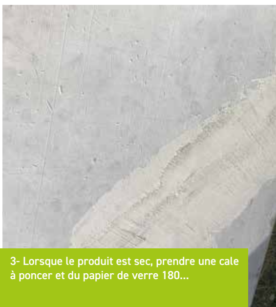
... et poncer la surface et la périphérie pour obtenir un résultat propre et homogène.
