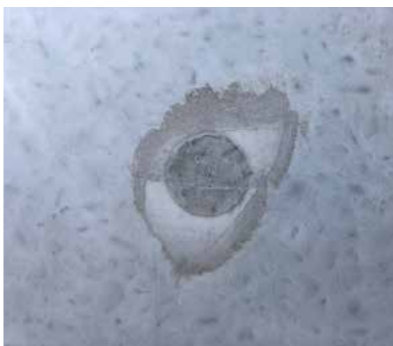
3- Supprimer les excédents de matière et lisser la surface. Laisser sécher. Passer une couche de finition avec l'enduit type Lankomur 101
