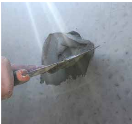
2- Remplir l'espace avec de l'enduit type Lankomur 102.
