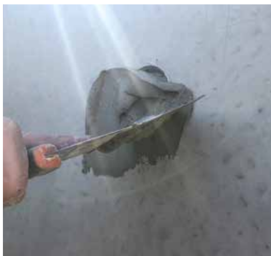
2- Remplir l'espace avec de l'enduit type Lankomur 102.
