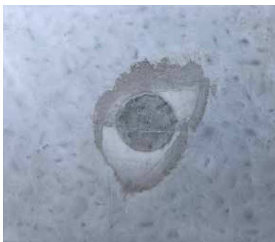
3- Supprimer les excédents de matière et lisser la surface. Laisser sécher. Passer une couche de finition avec l'enduit type Lankomur 101
