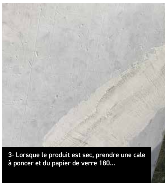
... et poncer la surface et la périphérie pour obtenir un résultat plan.
