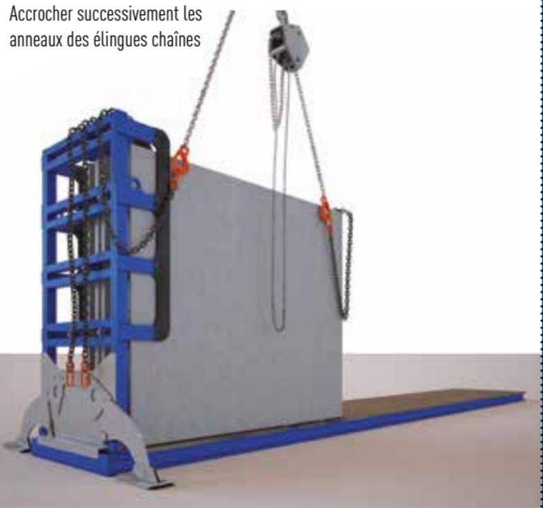
Respecter les principes de base de l'élingage (équilibrage des charges, utilisation du palan, respect des angles de levage).
